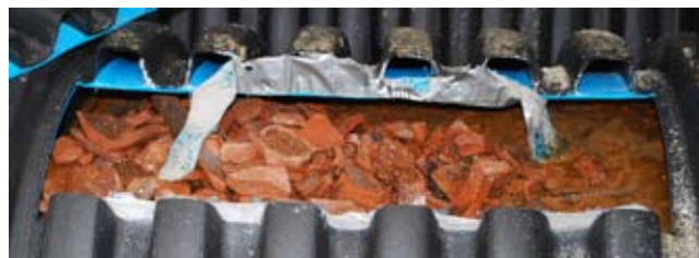
Olika skikt i filtertunnorna för rening av lakvattnet
